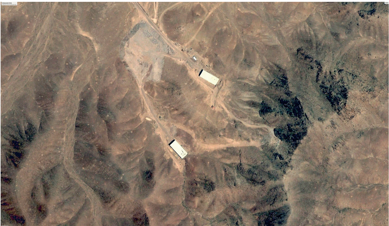
Abbildung 12: Im Juni 2004 verdeckten Gebäude die Eingänge zu dem in Bau befindlichen Tunnelsystem der Anlage Fordo. (Quelle: Google Earth)
