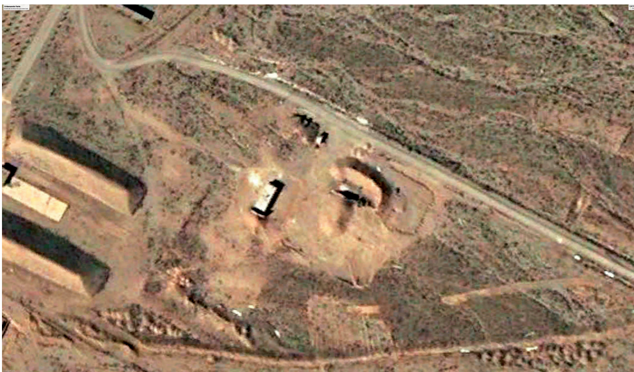
Abbildung 7: Golab Dareh im März 2004. Rechts der größere Bunker mit dem Schutzwall davor, links darüber der Eingang zum normal dazu liegenden kleineren Bunker. (Quelle: Google Earth)
